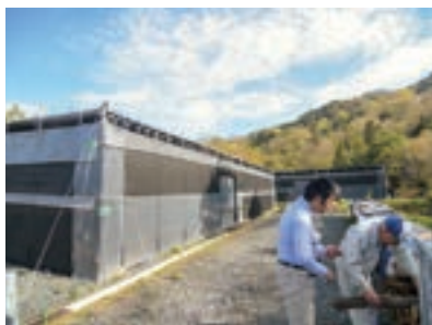
大規模な人工ほだ場を整備したことで、作業効率が格段にアップ。県内でも屈指の生産量を誇る。
