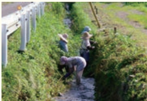
水路清掃の様子
