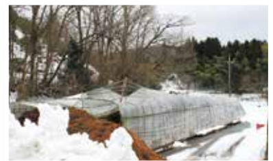
倒壊したビニールハウス
