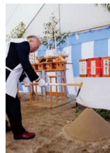
工事の安全を祈願して 鍬入れをする石川組合長
