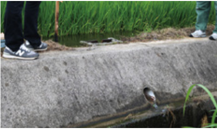
堰板設置時の水量
