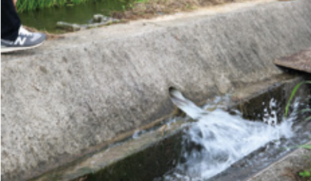
堰板未設置時の水量
