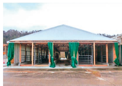
県央地区畜産総合センター
