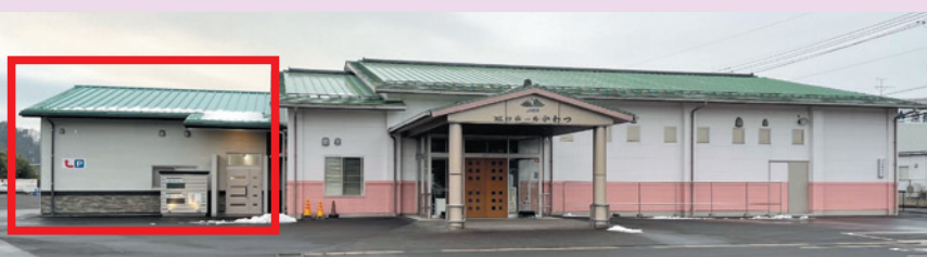
虹のホールかわつ外観(枠線部分が完成)
