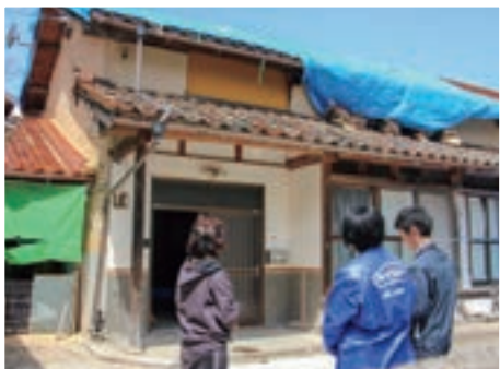
被害にあった建物の調査を行う職員
