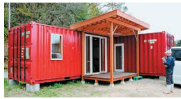
研修生が快適に過ごせるようにトイレ・シャワー・エアコンなどが完備されたコンテナハウスも設置しています
