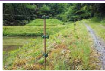
電気柵の設置
